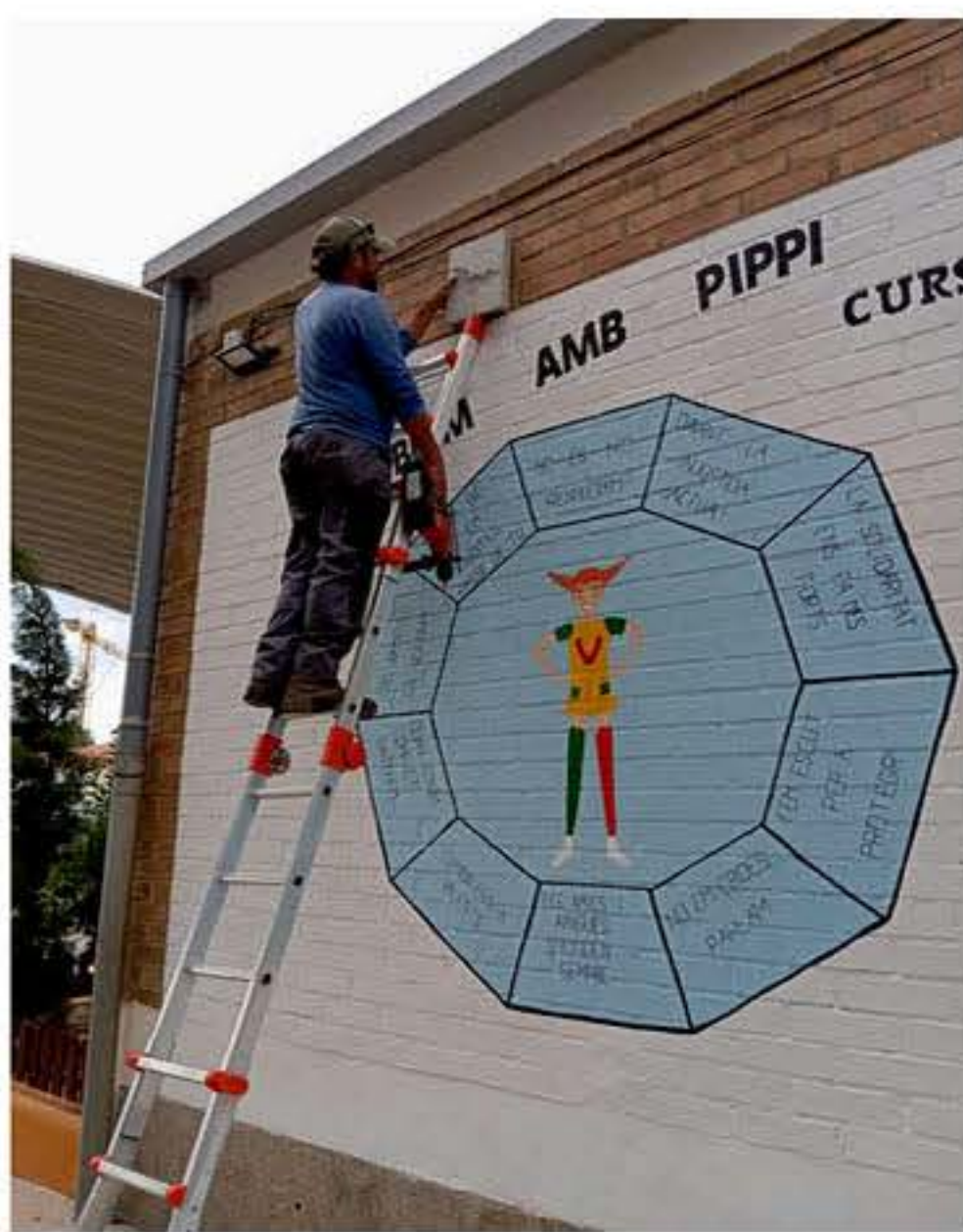
un treballador instal·la un dels nius. EPDA
