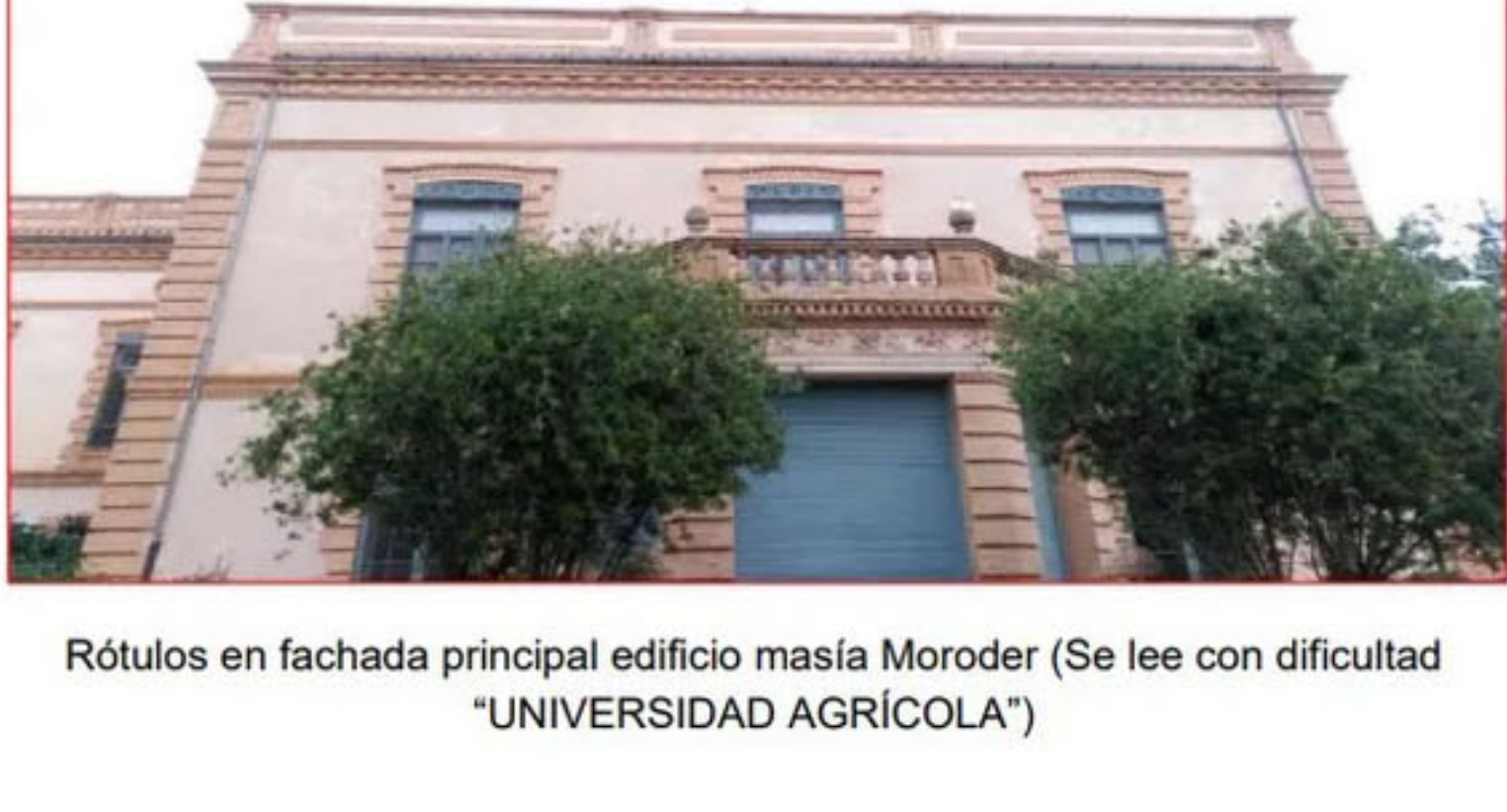
Rótulos en fachada principal edificio masía Moroder (Se lee con dificultad “UNIVERSIDAD AGRÍCOLA”)
