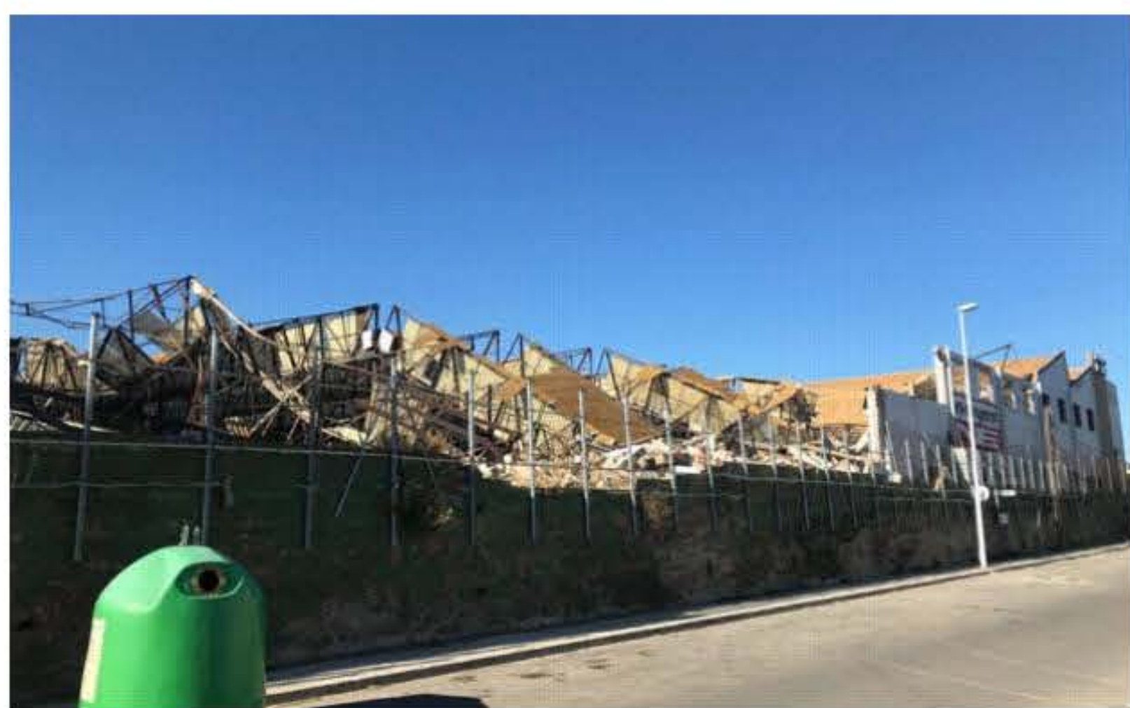
El estado actual de la antigua fábrica con una de las naves derrumbada. / A. D.
